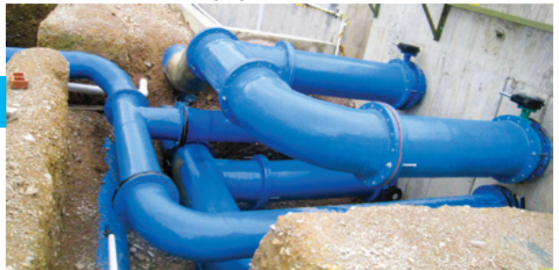
tubería en PRFV - PTAR Tunja - Boyacá. 120 LPS
